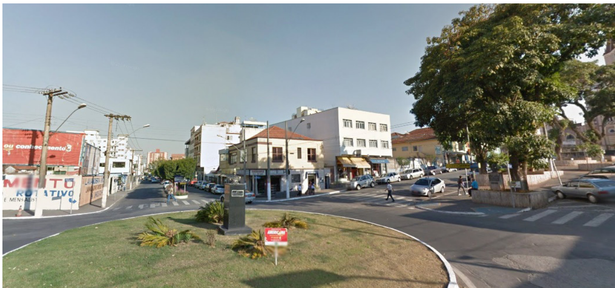
Avenida João Beraldo vai passar por obras de reforma e ampliação de seu sistema de drenagem
